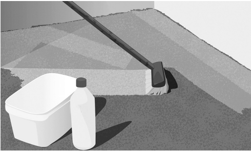
7. ábra: Tisztítsa meg és készítse elő a felületet
